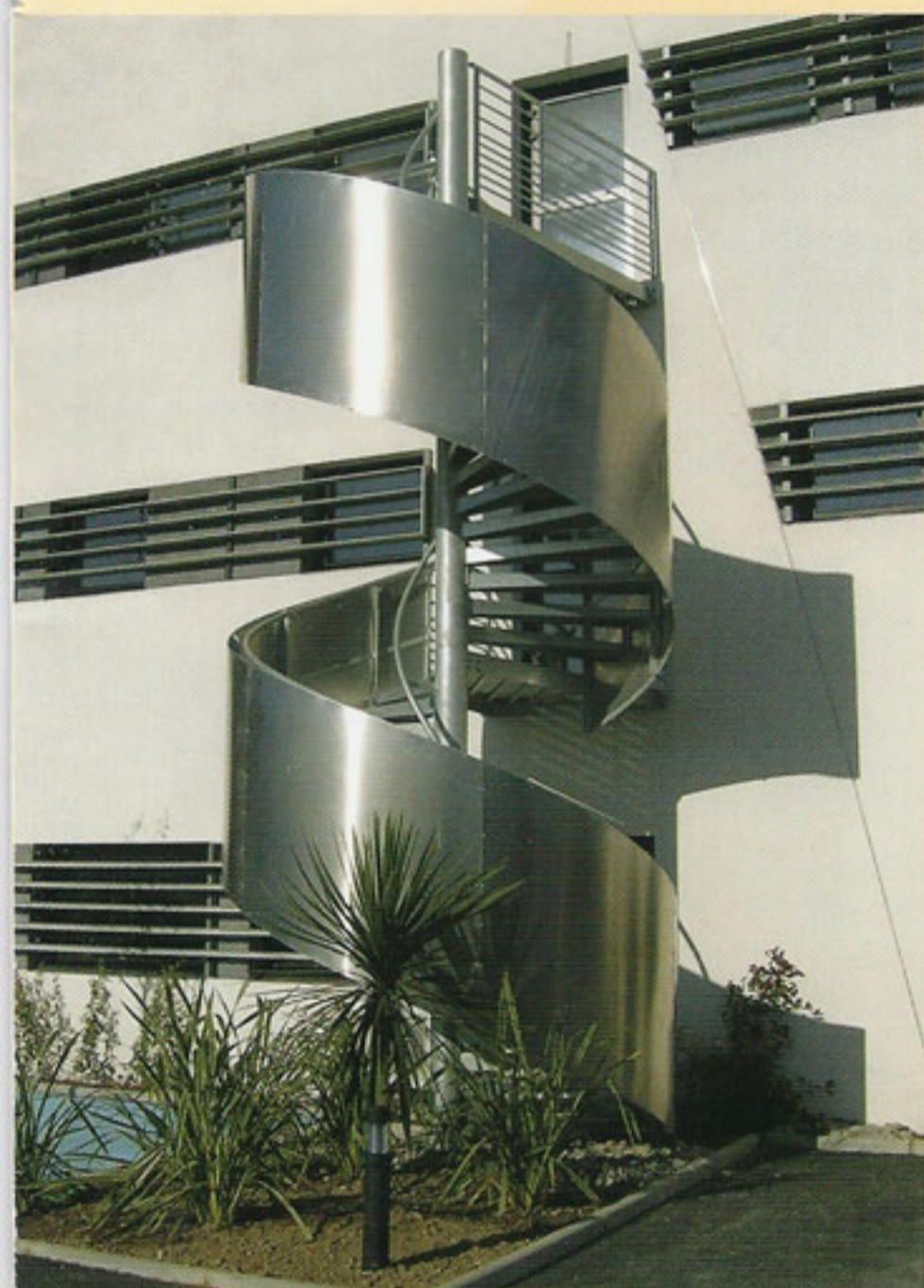
Ci-dessus escalier avec garde corps tôle pleine (Centre médical Seyne sur Mer)
